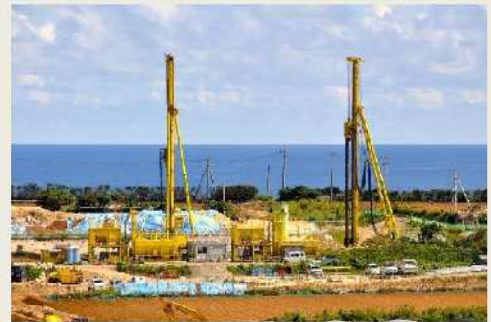
止水壁施工状況（国営沖永良部地区：知名町）
