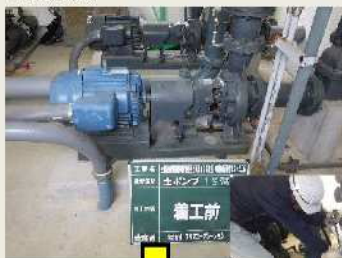
【中原加圧機場（枕崎市）】 （整備前）
