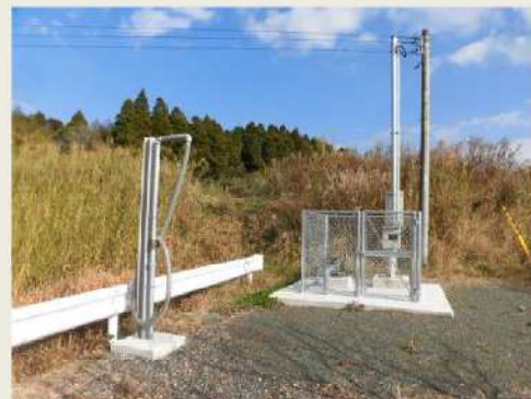
ポンプ、給水スタンドの整備（内田地区：阿久根市）
