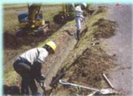
【水路の軽微な補修】
