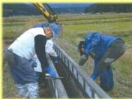
【地域住民による直営施工】
