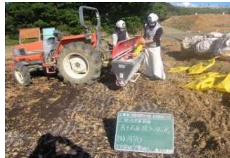
↑土層改良材散布
