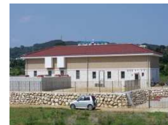
【余多揚水機場】
