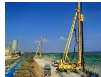
【地下ダム施工状況】
