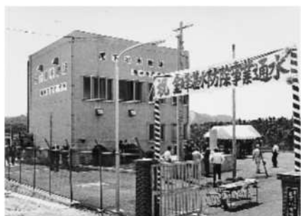
昭和56年度に完了した湛水防除事業 (写真は尾下排水機場)
