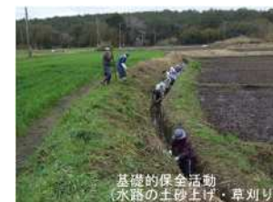
基本的保全活動 (水路の土砂上げ・草刈り) 水路の泥上げ、草刈り
