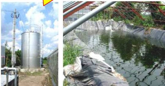
通水前の水源の様子
