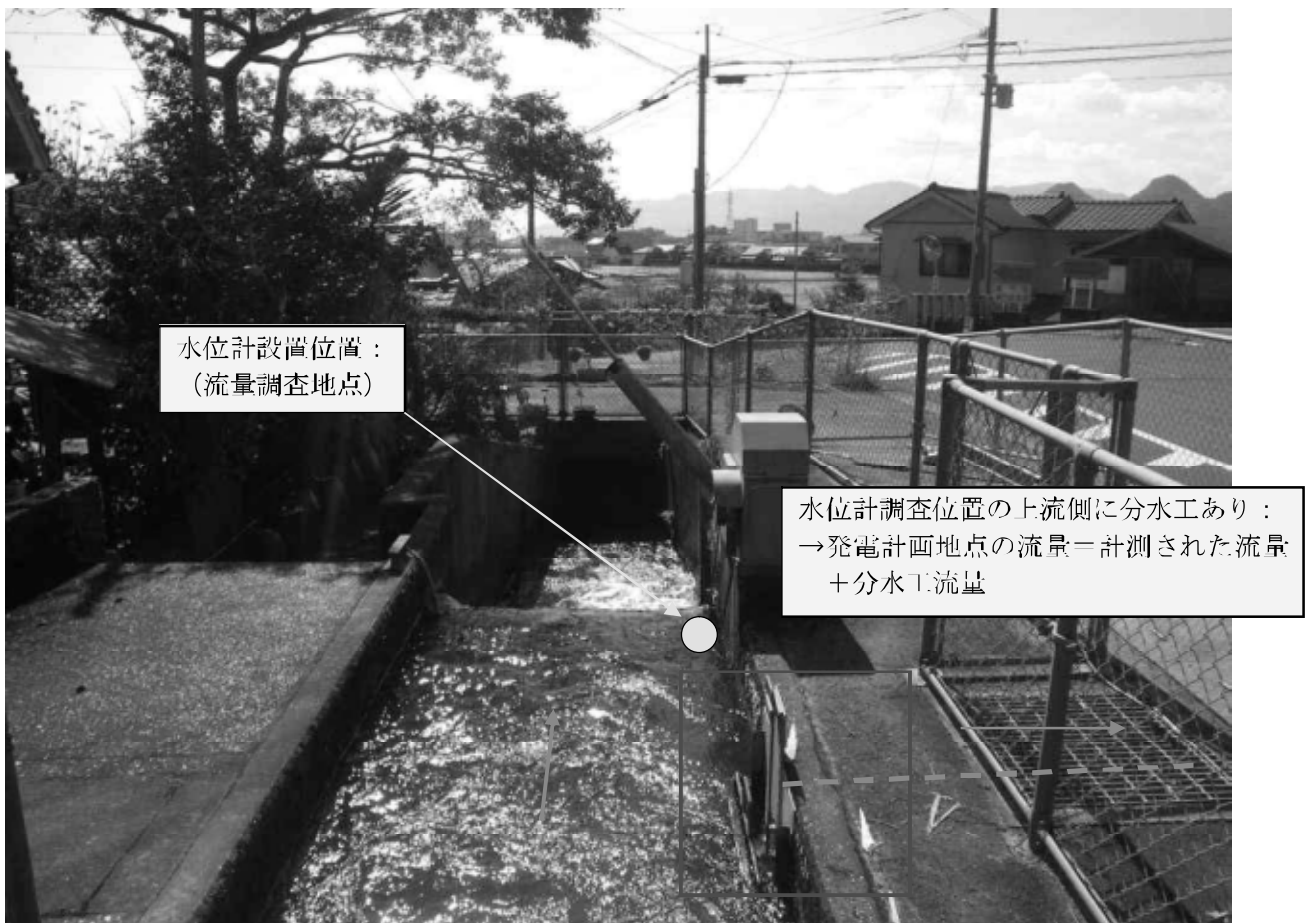
図 4.1-3 龍門滝地区高井田用水路 水位計調査地点
