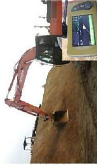
ICTバックホウによる暗渠排水掘削・法面整形
