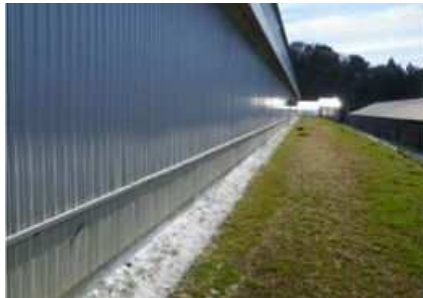
畜舎周辺の除草や木の伐採
