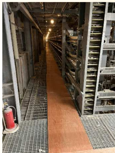
台車の通路にコンパネを設置
