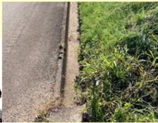
排水路の土砂を除去
