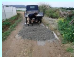
農道の路面補修
