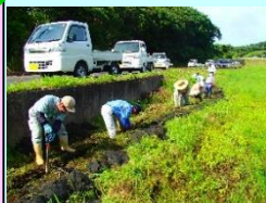
水路の泥上げ
