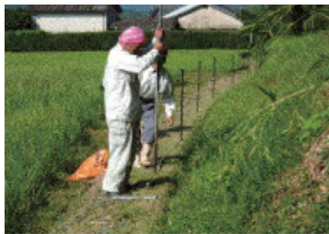
住民による侵入防止柵の設置
