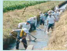
水路の泥上げ
