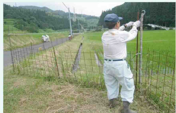
イノシシ侵入防止柵の設置
