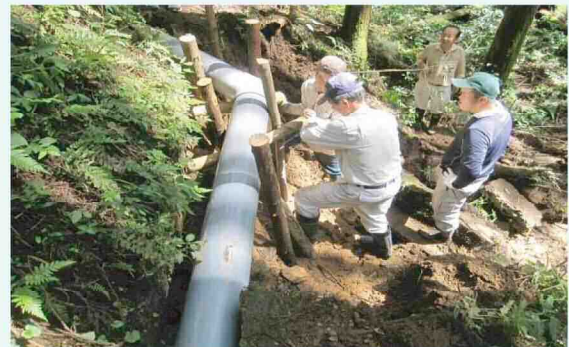
農業用水路の補修
