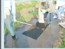
農道の部分補修
