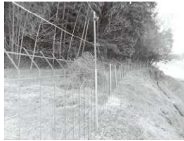
防護柵の試験的な設置
