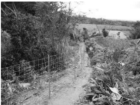
防護策等の設置状況
