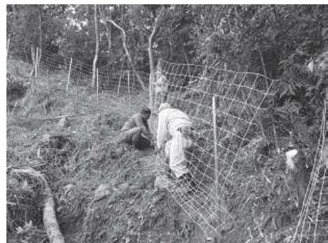
防止柵設置作業の様子
