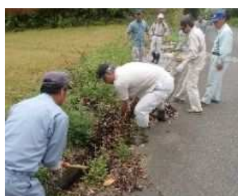
水路の泥上げ
