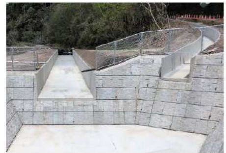
農地保全(排水路整備)
