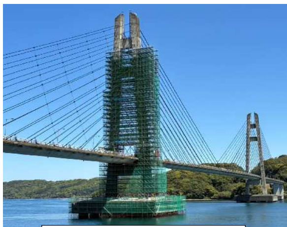
保全対策工事实施中の伊唐大橋（農道橋）
