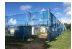
（防風ネットの設置）
