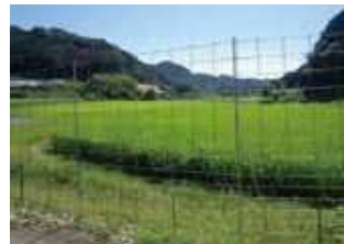
侵入防止柵の整備
