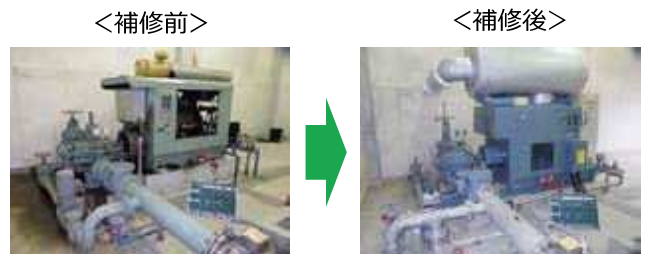
老朽化したポンプの補修
