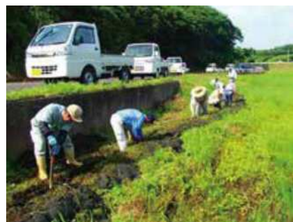
水路の泥上げ
