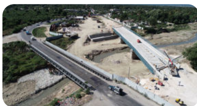
●海外での施工実績も多数!これはハイチ共和国で橋を架けている写真です。
