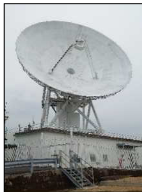
位于内之浦宇宙空间观测所 抛物面天线（左：20m，右：34m）
