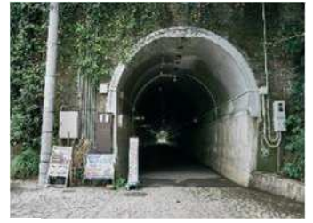
トンネルの入口
