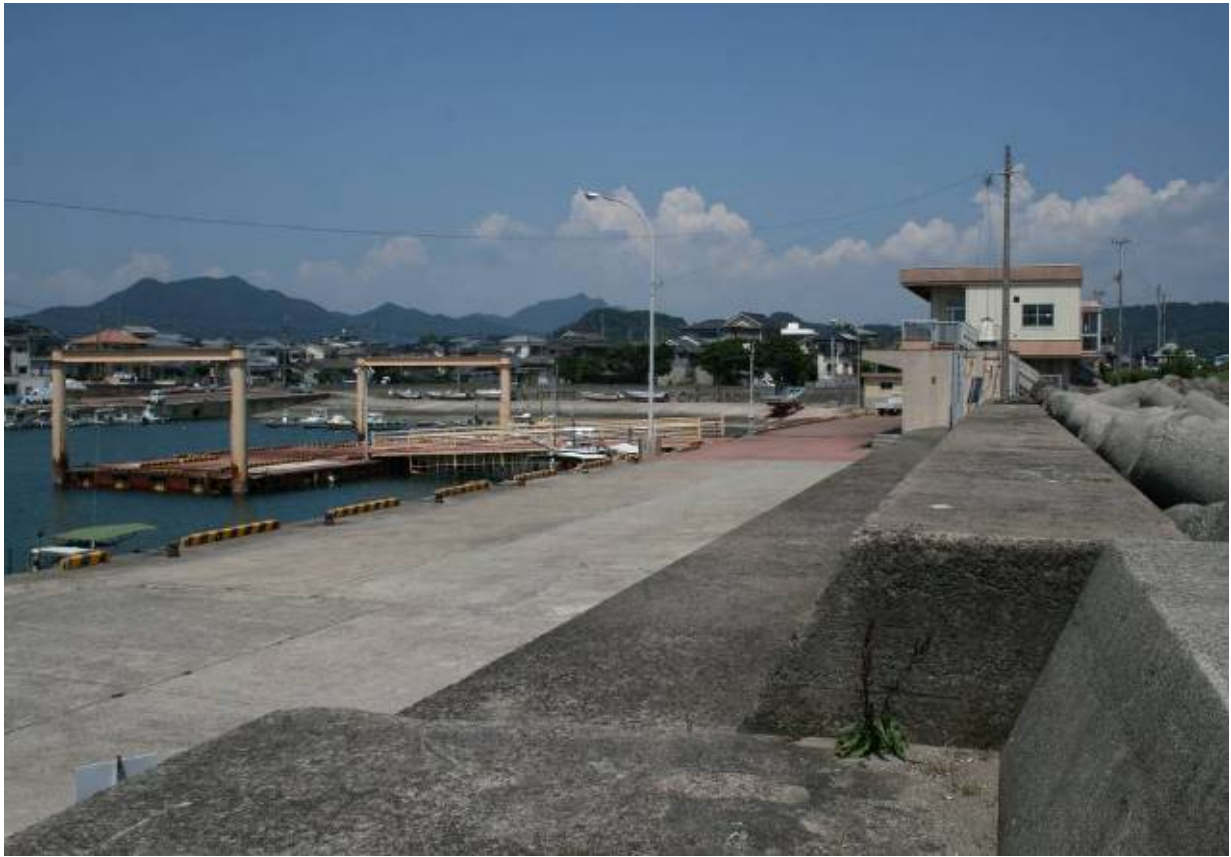
護岸改良(防風柵設置要望箇所)
