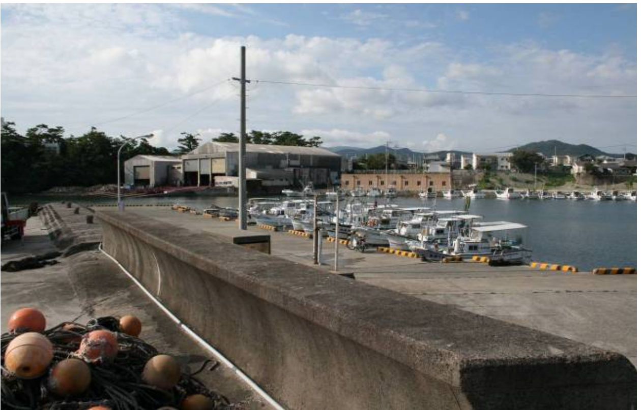
胸壁改良(防風柵設置要望箇所)
