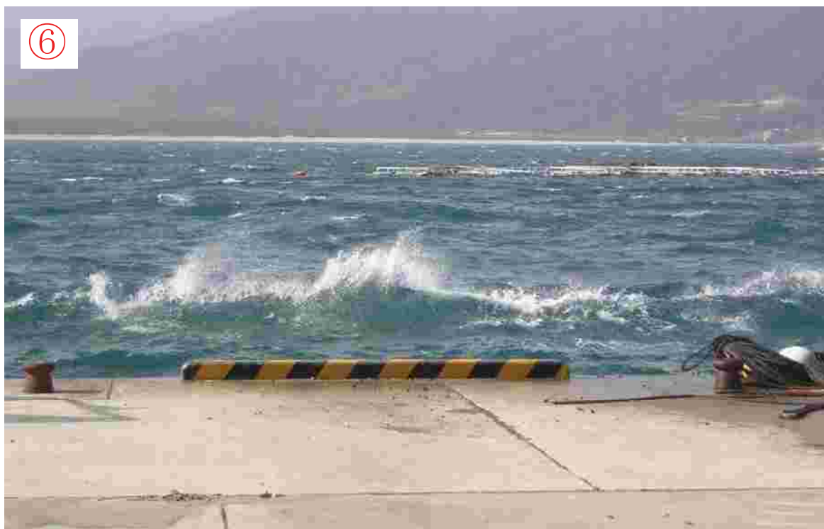
通常荒天時の小白木地区物揚場前面状況。静穏度が確保されていないため、漁船の係留ができなく、定置網等の漁具の入れ替え準備などができない。
