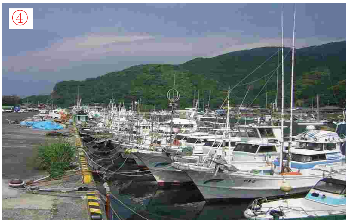
台風接近前港内状況。 安全係船岸の不足により、大型巻き網船の背後に小型船を係留しなければならず、台風通過後には、大型巻き網船が安全綱を解除しなければ、小型船は出航できなくなる。
