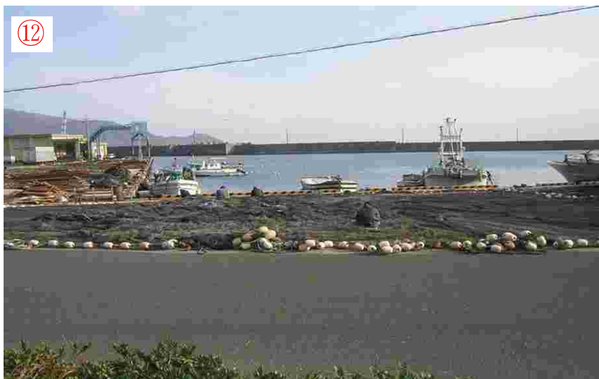
定置網補修状況。用地が狭いうえ、補修を行いながら広げていくため、道路上へ網が出てしまい、安全性が確保されていない。
