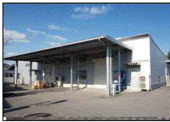
九州工場外観
