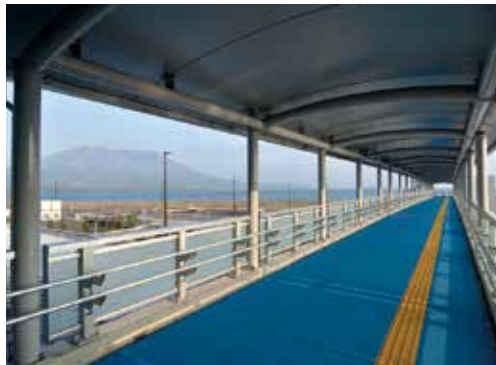
駐車場とターミナルの間に架かる歩道橋
