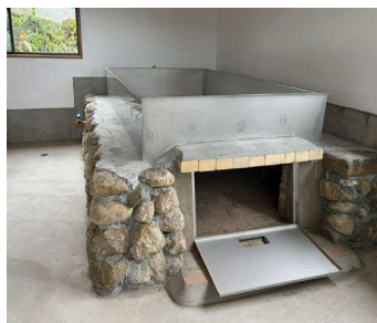
①新設した製塩所には、海水を炊くための石造りの釜を設置
