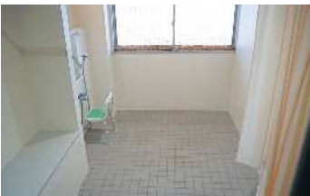
管理棟内の車いす利用者用シャワールーム
