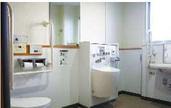
管理棟内の多目的トイレ
