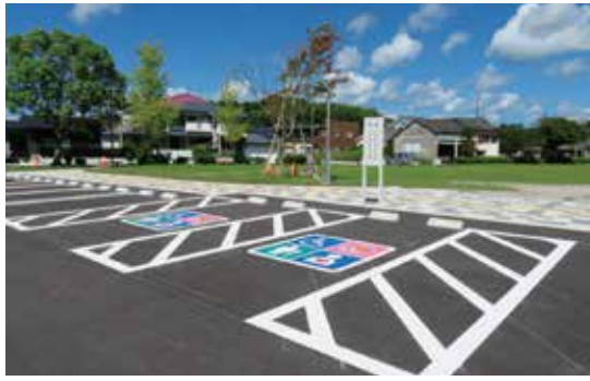
障害者優先駐車場を2箇所整備
