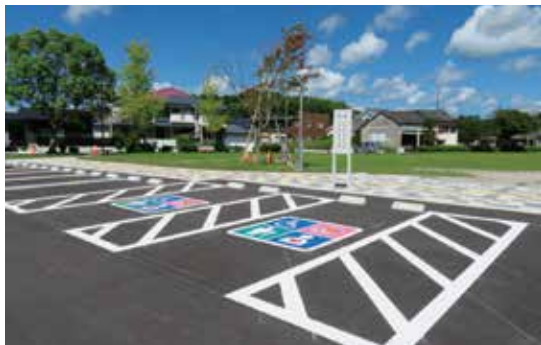
障害者優先駐車場を2箇所整備
