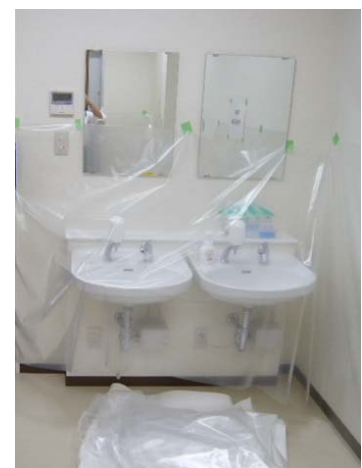
図 4-2 搬出できないものの養生の例
