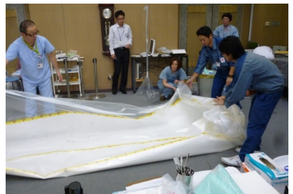
図 4-12 養生シートの撤去
