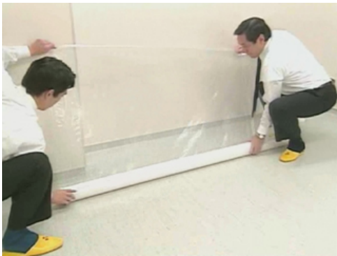
図 4-3 壁面養生の例
