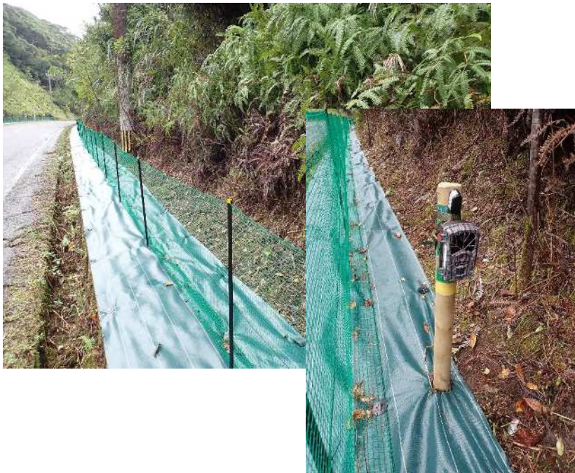
防護柵やカメラの設置
