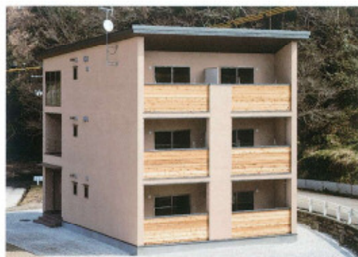
高知おおとよ製材株式会社社員寮(高知県) 2014年に日本で初めて大臣認定によるCLT構造で建設された3階建て共同住宅である。
