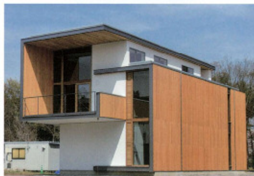
CoCo CLT つくばCLT実験棟(茨城県) 実験棟では、材料から得られる空間特性や施工性の確認の他、室内の温熱環境や防音性能等を検証している。
