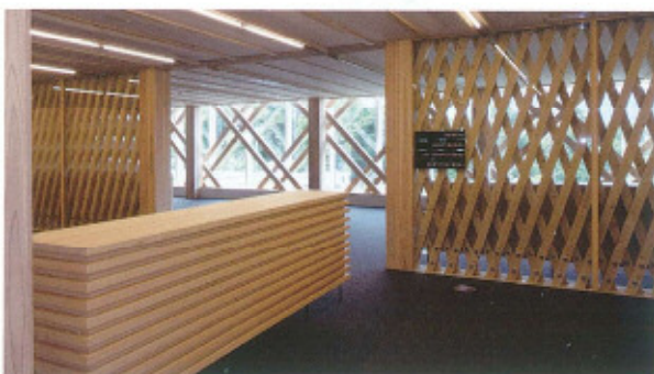
高知県自治会館庁舎(高知県) 天井仕上げ材を準不燃材料とすることで、木製ブレースを現して使用し、独立柱にスギ材を張った建築例 天井には、見付面積を天井面の面積の1/10以下としたルーバー(スギ)を用いている。
