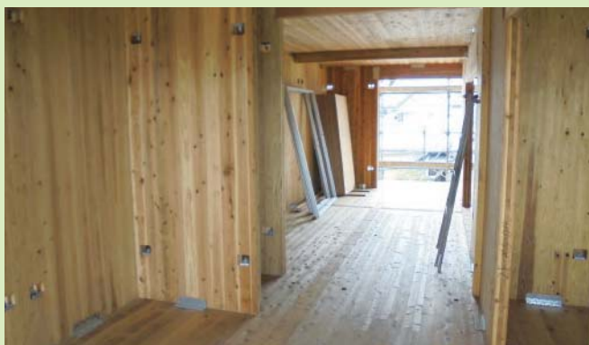
●集合住宅（建筑情况）※CLT面板工法
