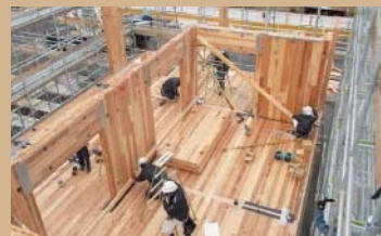
●CLT面板工法的建筑情况
