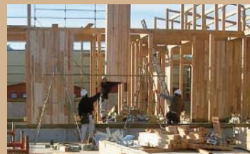
●木造轴组构造法+CLT的建筑情况
