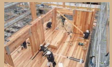
●CLTパネル工法の建築状況
