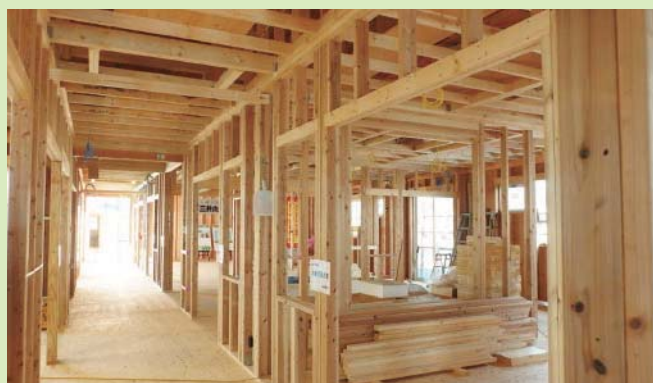
●保育園(建築状況) ※2×4部材を利用
