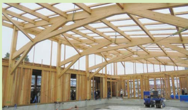
●学校の体育館(建築状況) ※CLTと集成材を利用
