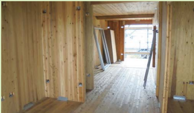
●集合住宅(建築状況) ※CLTパネル工法
