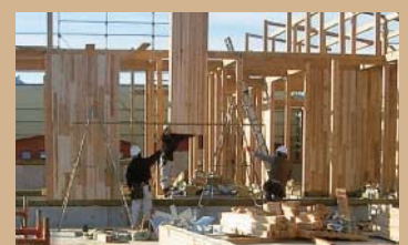
●木造軸組構法+CLTの建築状況
