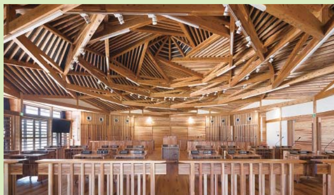
●役場の議会棟ホール
