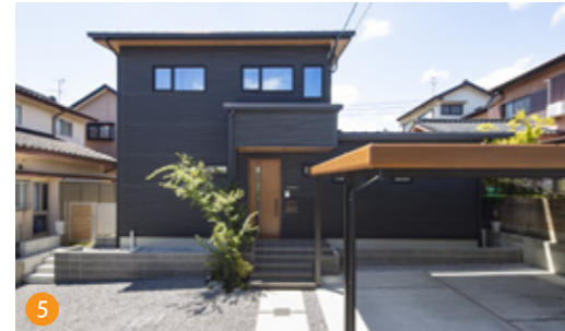
5 緩やかな傾斜のガルバリウム鋼板の屋根に太陽光パネルを搭載。高さをそろえた窓がシンプルな外装を美しく引き締めています
