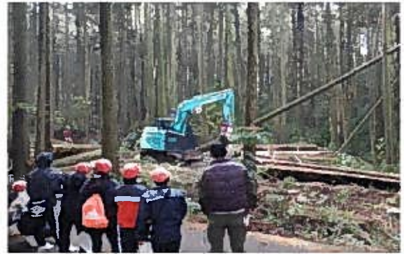
【伐採現場見学】
