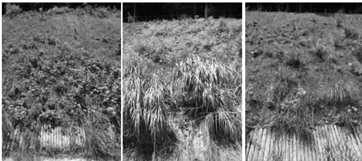
図 吹付緑化試験地の現況 (H27.8撮影)
