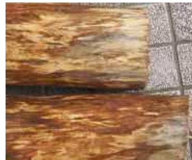
写真-1 木口からの青変菌の侵入
