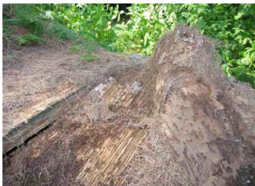
写真 16 堆積の下はシロアリによる食害痕
