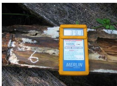
写真12 床版の裏側 (MC40%)
