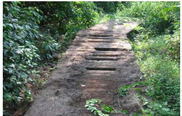
写真5 載荷確認後の木栈道
