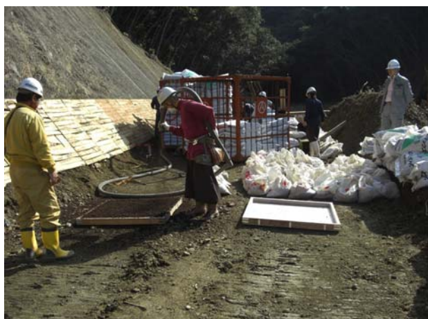
写真3 吹付箱への吹付状況 (2009年2月)
