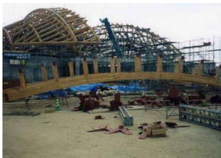
写真1 笠井町 奄美パーク (リュウキュウマツ大断面集成材使用) 建築面積:3,163 m 2 , 木材使用量:316 m 3
