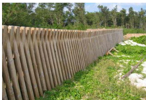
写真1 リュウキュウマツを用いた木製防風柵工
