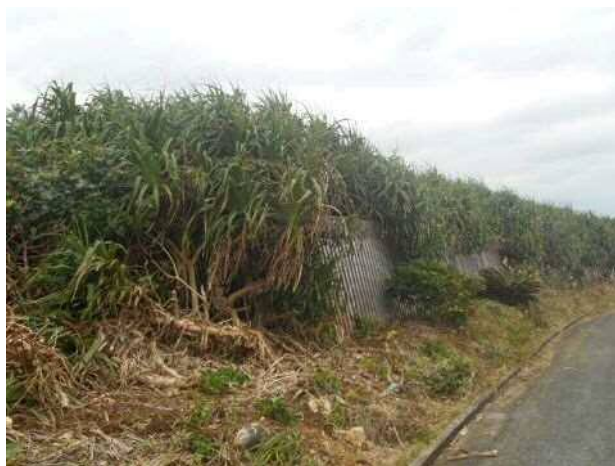
写真 1. 施工された木製防護柵
