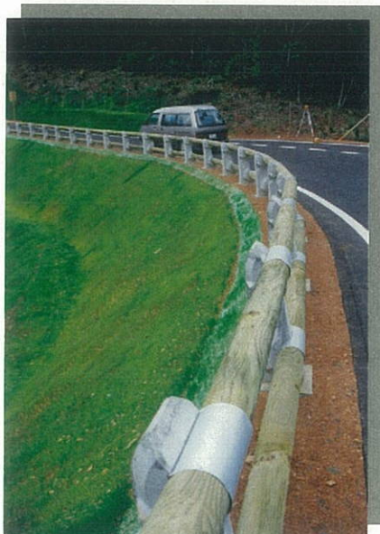
木製ガードレール
