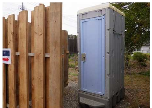
トイレ仮囲い
