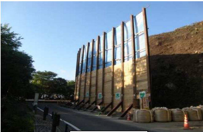
道路整備工事
