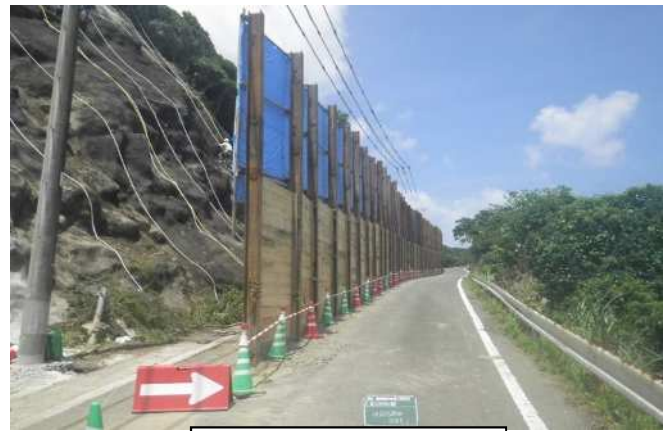
道路災害防除工事
