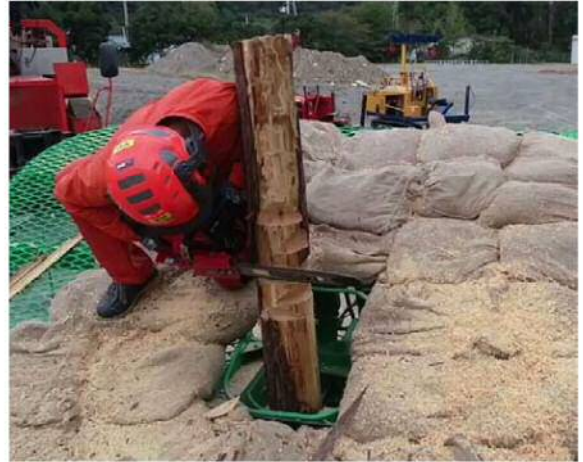
傾斜伐倒装置を活用した研修
