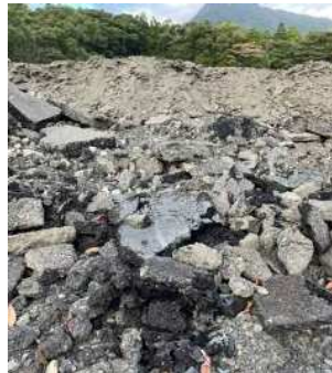
アスファルト
