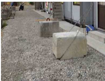
埋戻材（仮設工）
