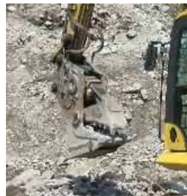
油圧ショベルによる小割作業 (磁選付き小割機) (鉄筋・異物除去)
