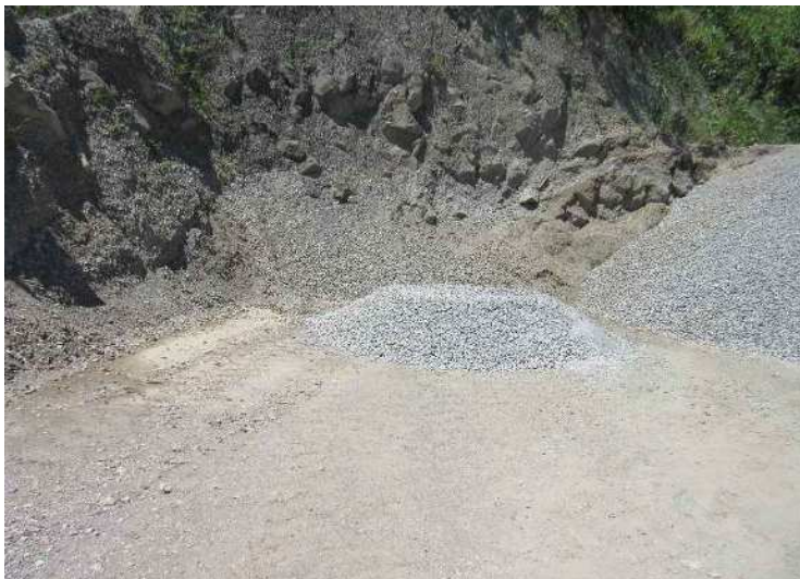
RC-40(Co50%+新材50%) タイヤショベルで攪拌してから ストック
