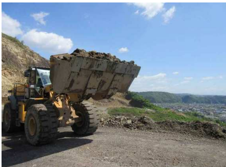
原材料投入ホッパー (Co50%,新材50%を それぞれ投入)
