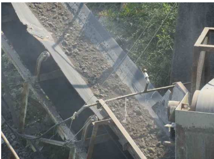
シュレッダー後の様子 * 粉塵対策 (散水)
