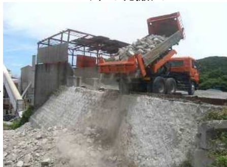
コンクリート塊搬入
