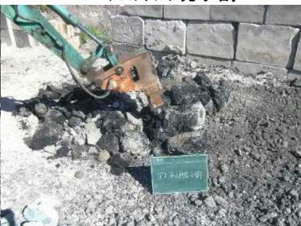
アスファルト塊小割
