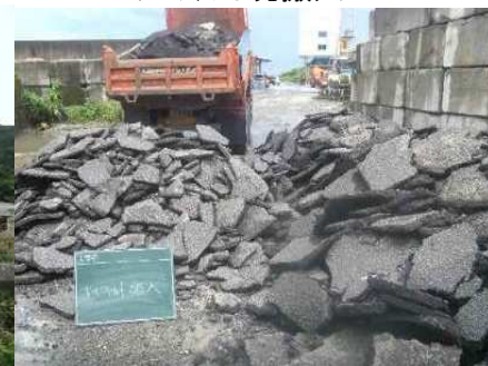
アスファルト塊搬入
