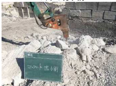
コンクリート塊小割
